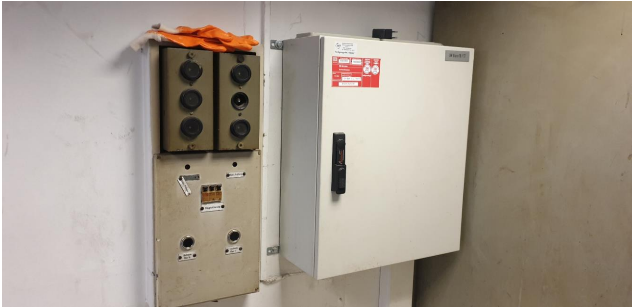
Foto 14: 14_50Hz-Verteilung Beleuchtung Überdachung 16_17 in Aufsichtshäuschen Bahnsteig Gl. 16_17.jpg
