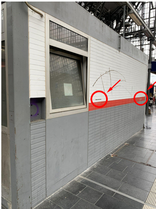
Bild 41: Probenahmestellen Fugenmaterial Mauerwerk (Blickrichtung SW) (05.10.2023)
