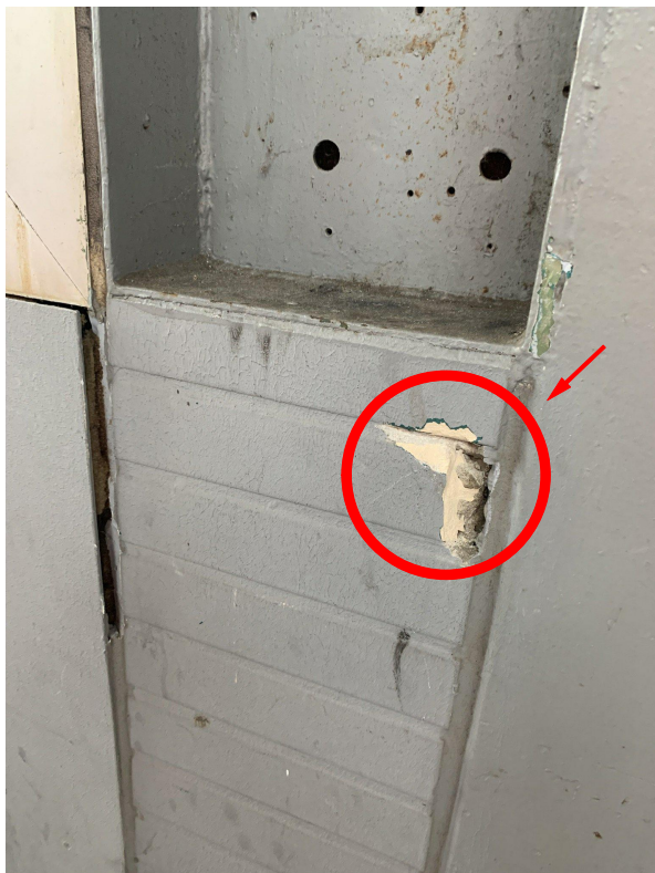
Bild 44: Detail Probenahmestelle Fugenmaterial Mauerwerk (Blickrichtung SW) (05.10.2023)
