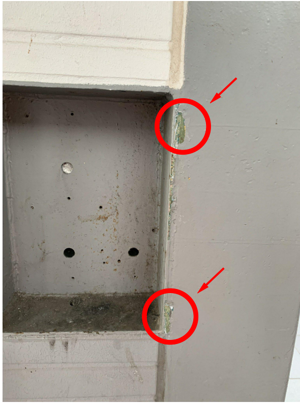
Bild 39: Detail Probenahmestellen Anstrich Stahlstützen (Blickrichtung NW) (05.10.2023)
