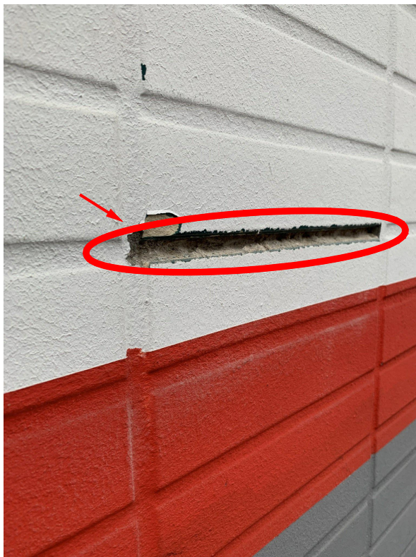
Bild 42: Detail Probenahmestelle Fugenmaterial Mauerwerk (Blickrichtung SW) (05.10.2023)
