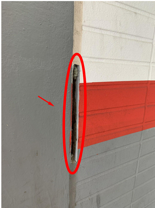
Bild 40: Detail Probenahmestelle Abdichtung Fenster + Stahlstütze zu Mauerwerk (Blickrichtung N) (05.10.2023)
