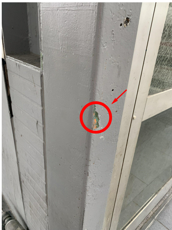
Bild 38: Detail Probenahmestelle Anstrich Stahlstützen (Blickrichtung W) (05.10.2023)
